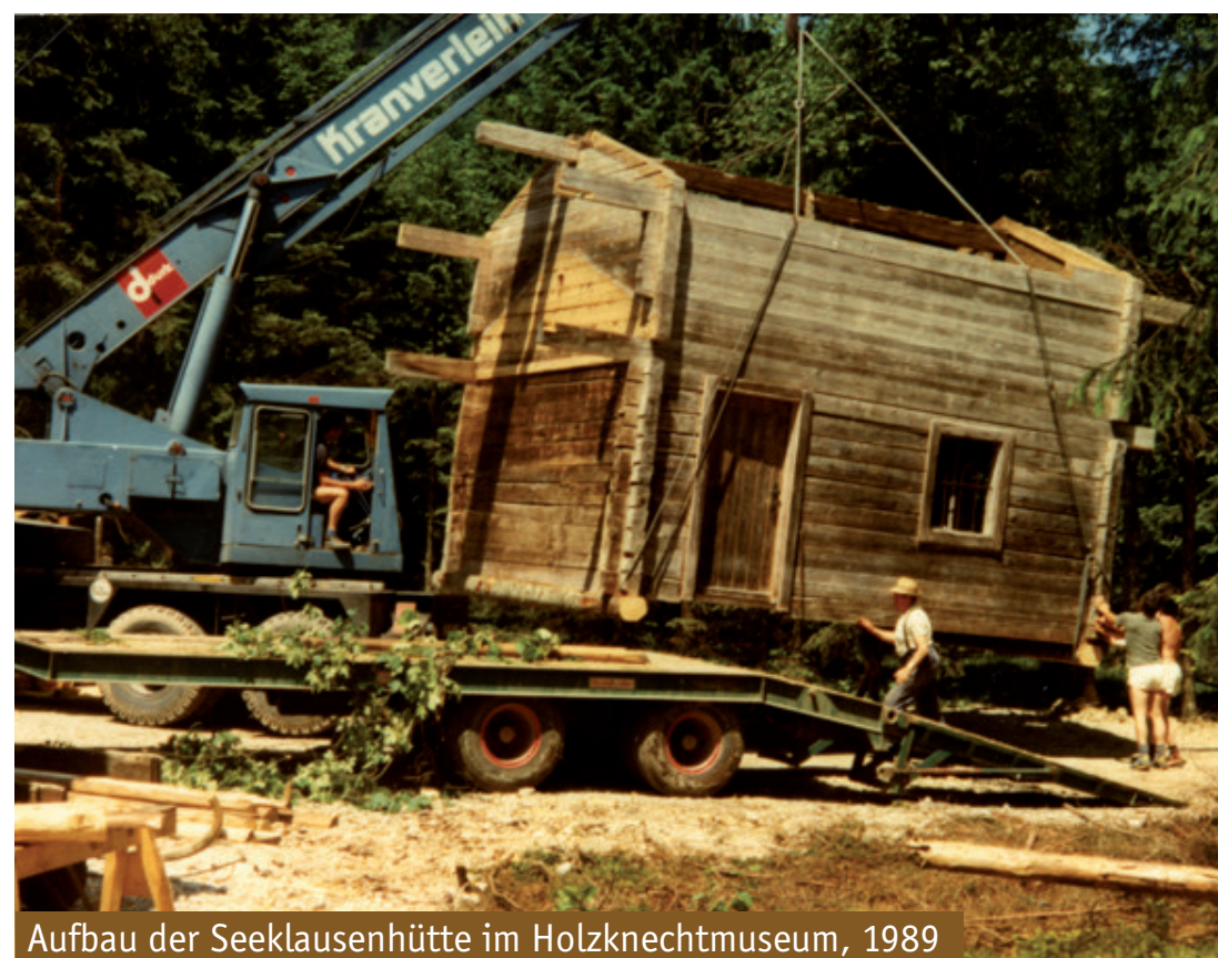
Aufbau der Seeklausenhütte im Holzknechtmuseum, 1989
